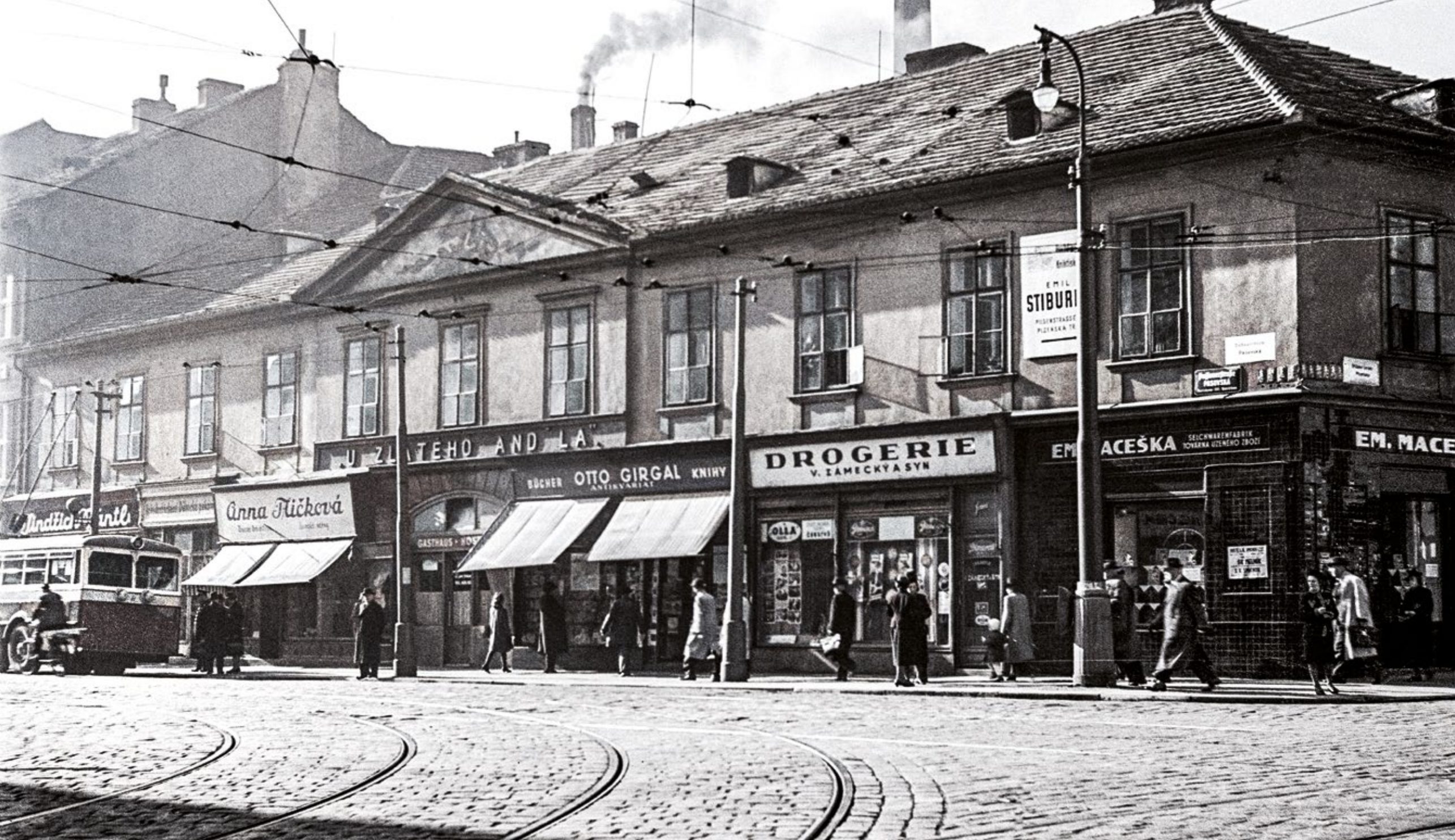
Dům U Zlatého anděla na Smíchově v roce 1940. Zbořen byl o čtyřicet let později, ale křižovatka se podle něj jmenuje dodnes. Vlevo je vidět zadní část odstaveného trolejbusu Praga TOT.
